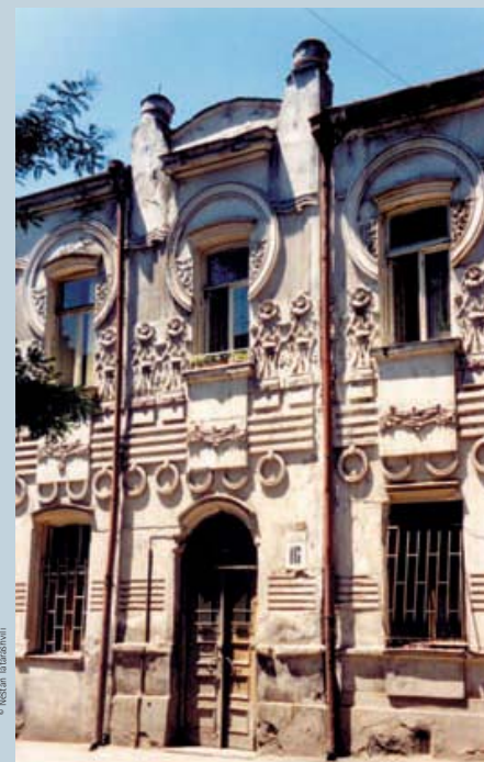
Architect unknown. 1903. 4 Kikodze St. Dwelling. Arquitecte desconegut. 1903. c. Kikodze, 4. Habitatge.
